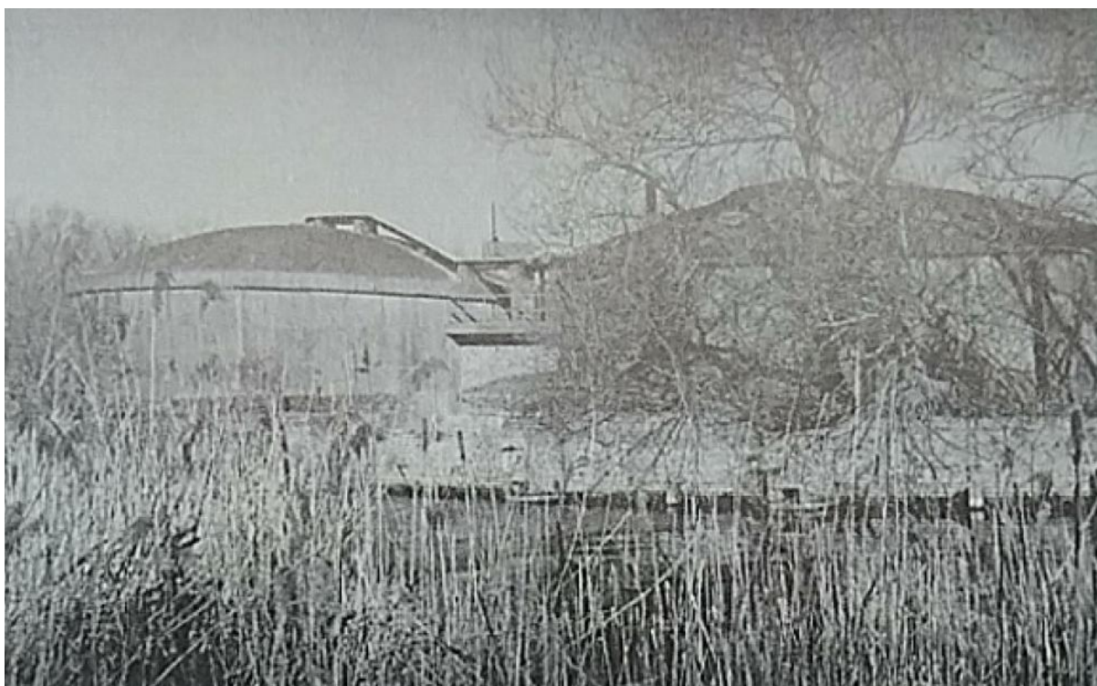
Figuur 4. Het waterzuiveringsstation in Groenendijk, Nieuwpoort, op de locatie waar nu duingebied en permanente poelen aanwezig zijn.
